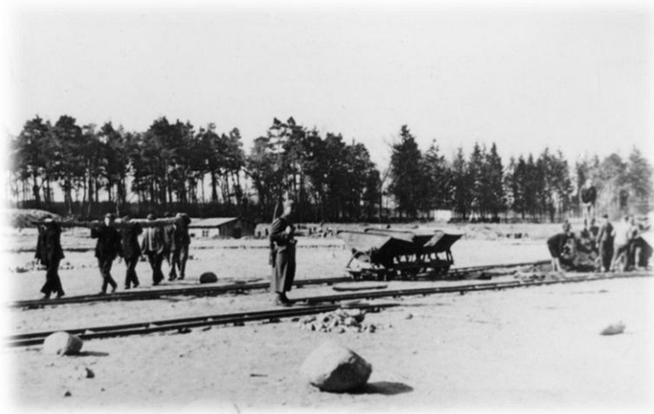
Zdjęcie 79. Budowa obozu w Potulicach.
